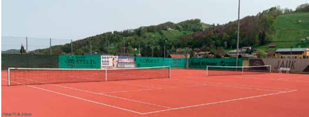
Nach den massiven Schäden durchs Hochwasser mussten wir die Sandplätze komplett erneuern. Der neue Belag (ForceCourt2) hat viele Vorteile und kann fast bei jeder Witterung bespielt werden.
